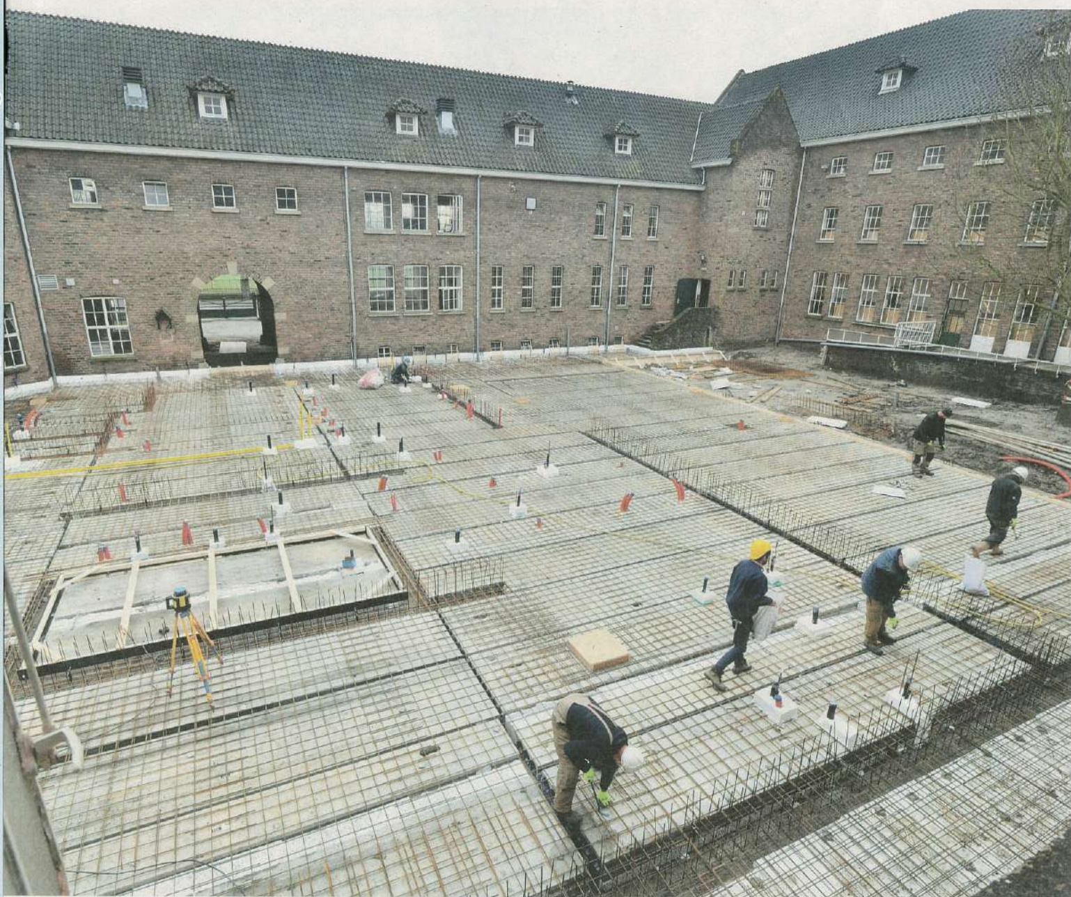
De oude vloer is verwijderd. Het Klein Arsenaal krijgt een nieuwe fundering met daarop een vrije, stalen constructie om de geplande evenementenzaal te kunnen dragen. Foto's: Erald van der Aa
